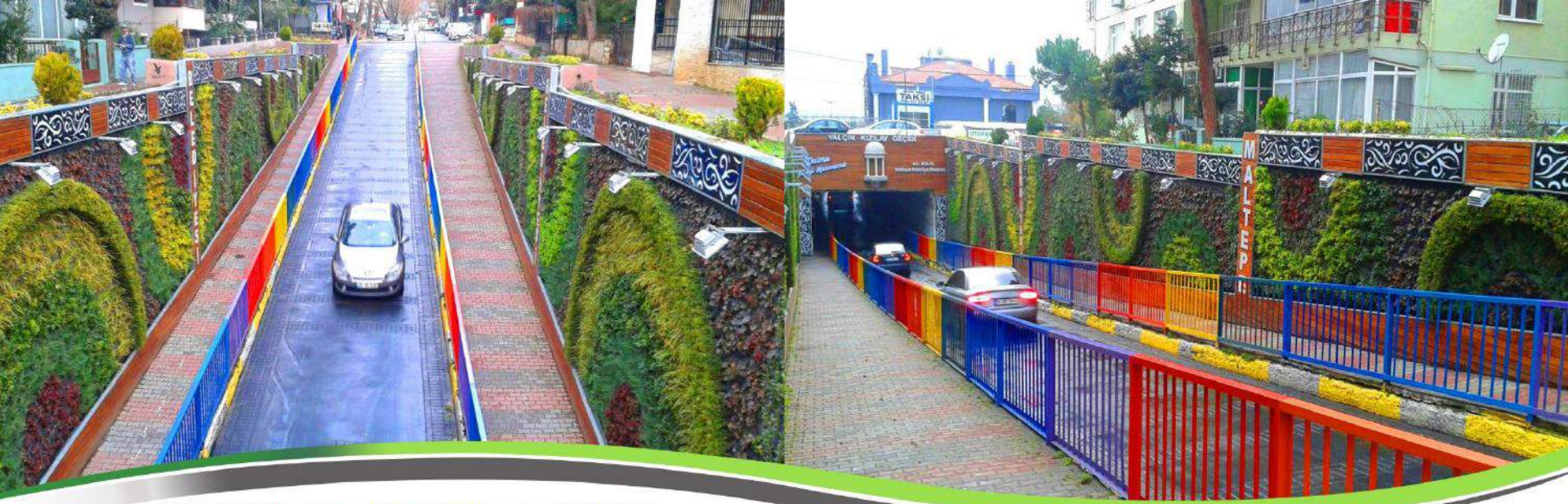
MALTEPE YALÇIN KIZILAY GEÇİDİ DİŞ MEKAN DİKEY BAĞÇE UYGULAMASI
