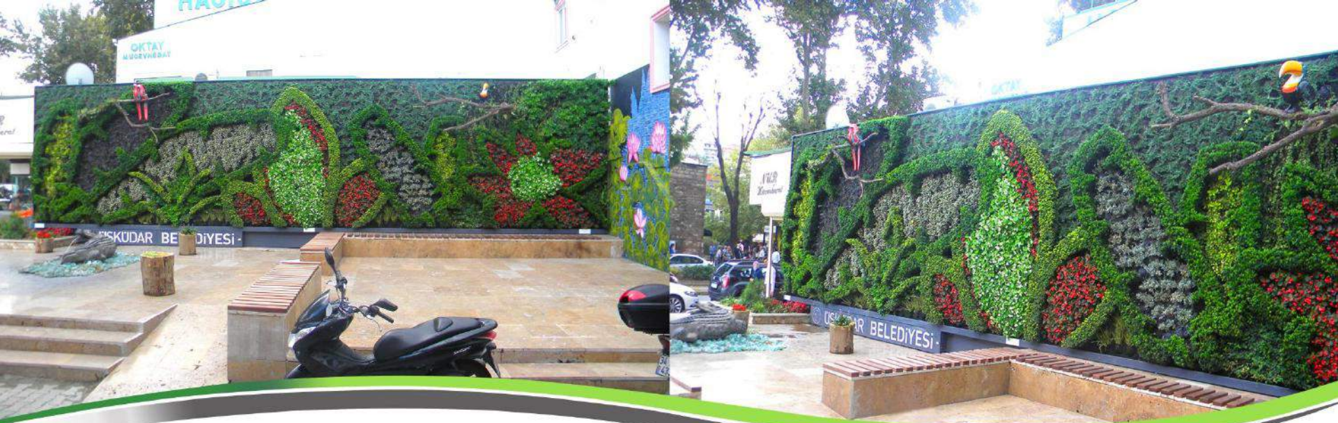
ÜSKÜDAR BELEDİYESİ-KUYUMCULAR ÇARŞISI DIŞ MEKAN DİKEY BAHÇE UYGULAMASI
