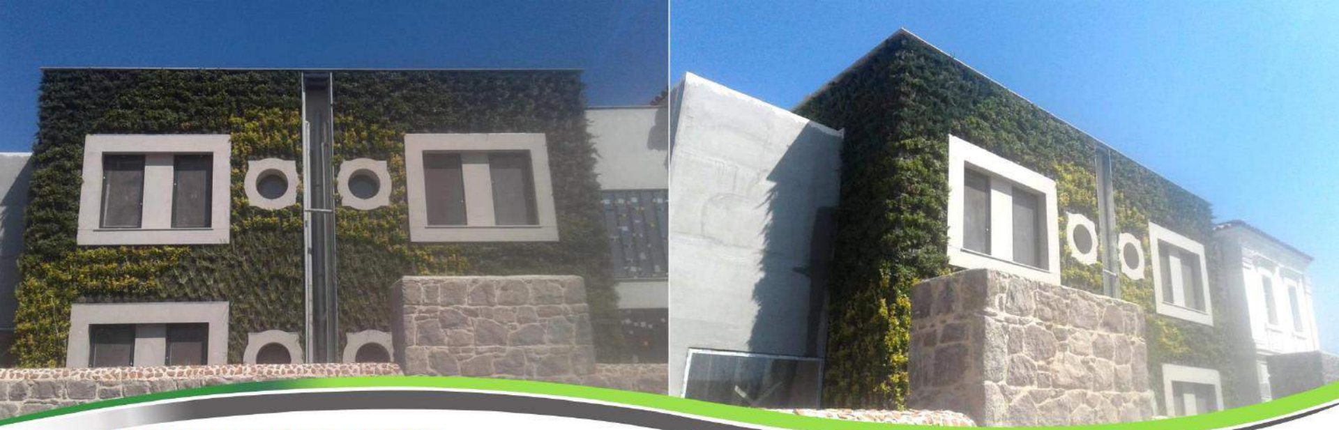
BODRUM MUSEUM HOTEL DIŞ MEKAN DİKEY BAHÇE UYGULAMASI
